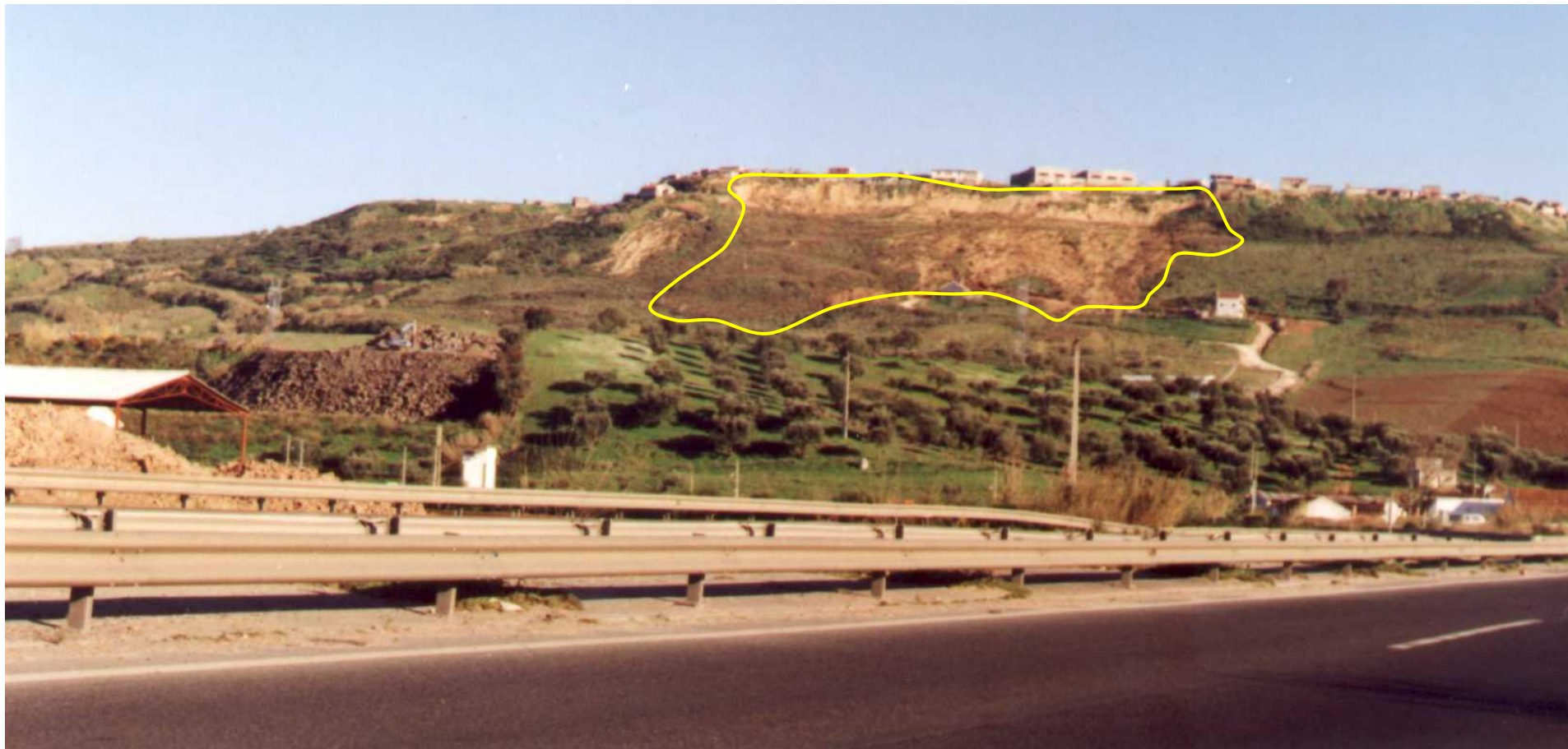
Deslizamento de Quinta da Boavista, Loures) Dezembro 1989
